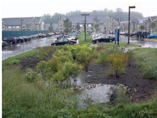
Rysunek 5. Zbiornik chłonny wykorzystywany w czasie pogody suchej jako teren rekreacyjny (schemat) i odbierający wodę z terenu ulic i parkingów
