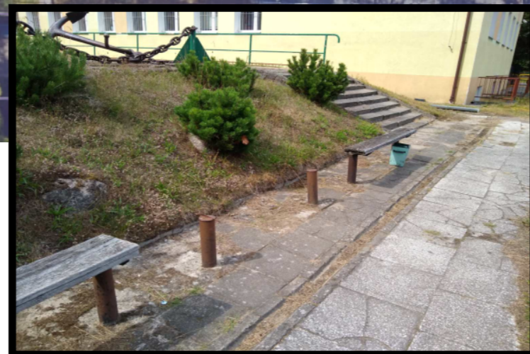
ZNISZCZONE ELEMENTY ARCHITEKTURY
