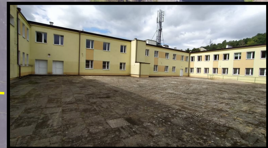
BETONOWY PLAC NIEPRZYSTOSOWANY DO UCZNIÓW Z OGRANICZONYMI MOŻLIWOŚCIAMI PORUSZANIA
