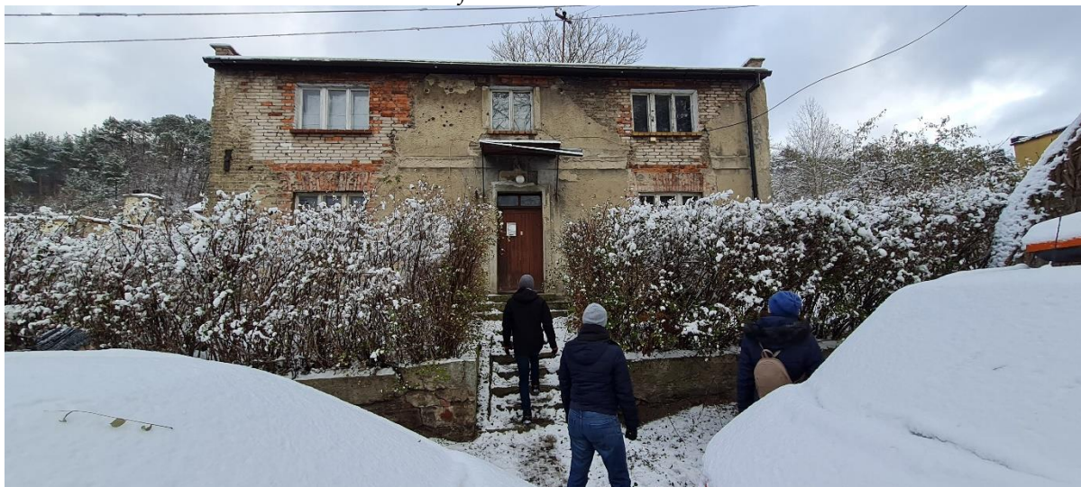
Fot. Dawna biblioteka przy ul. Demptowskiej 105 – na elewacji widać ślady strzałów z II wojny światowej.
