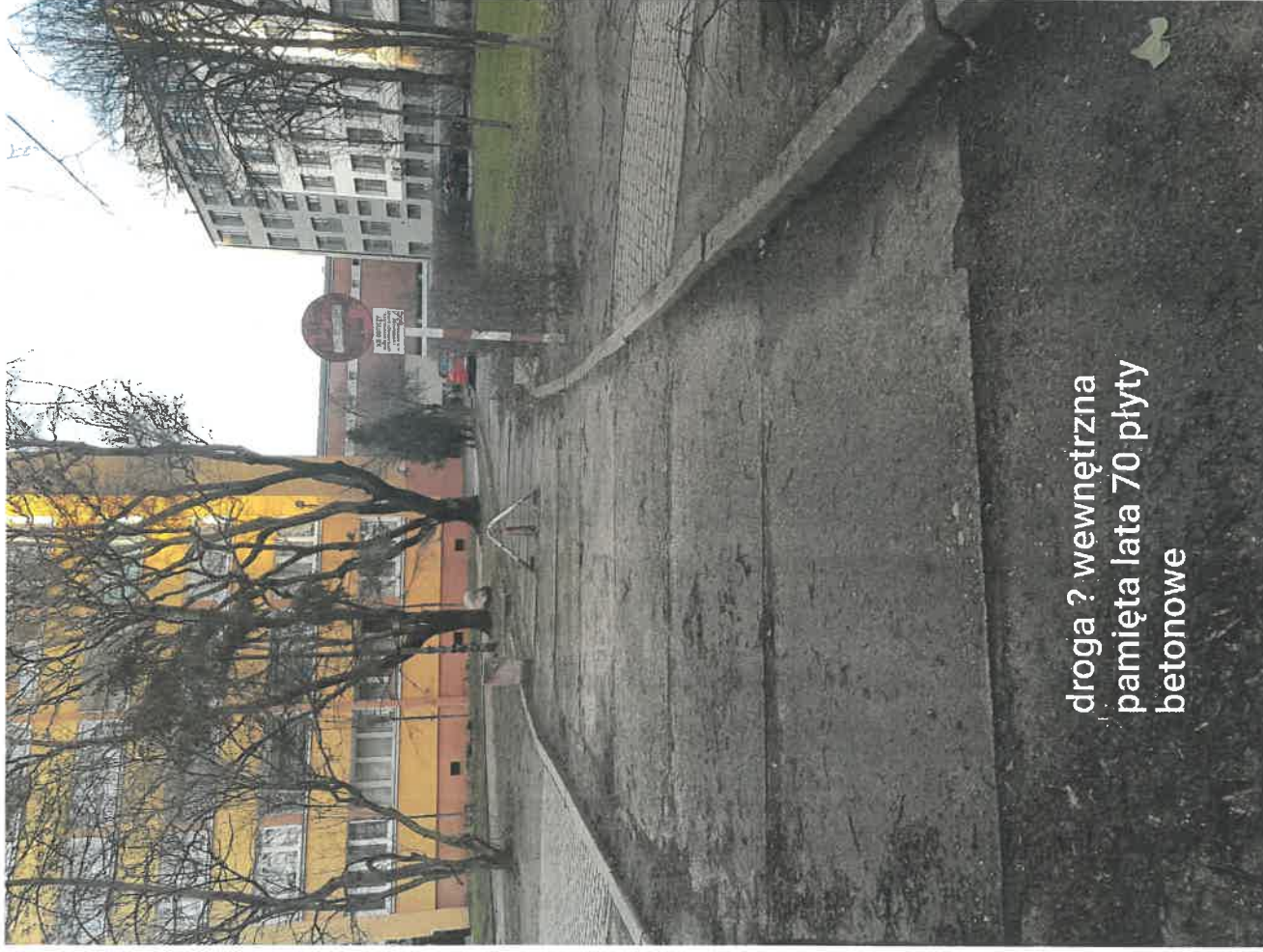
"ciekawe patchworkowe połączenie płyt betonowych i chodnika" Tu długo "stoi woda".
