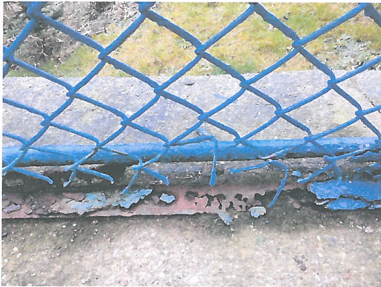
ZDJĘCIE 3: STAN OGRODZENIA
