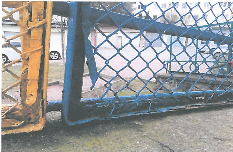
ZDJĘCIE 4: STAN OGRODZENIA
